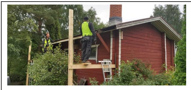
Kauan odotettu kattoremontti toteutui syyskuun alussa. Todella tehokkaat kaksi miestä ja kaksi vuorokautta – huopakatto vaihtui peltikatoksi.
